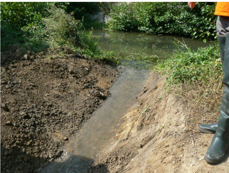
Photo de la prise d'eau sur le bief
