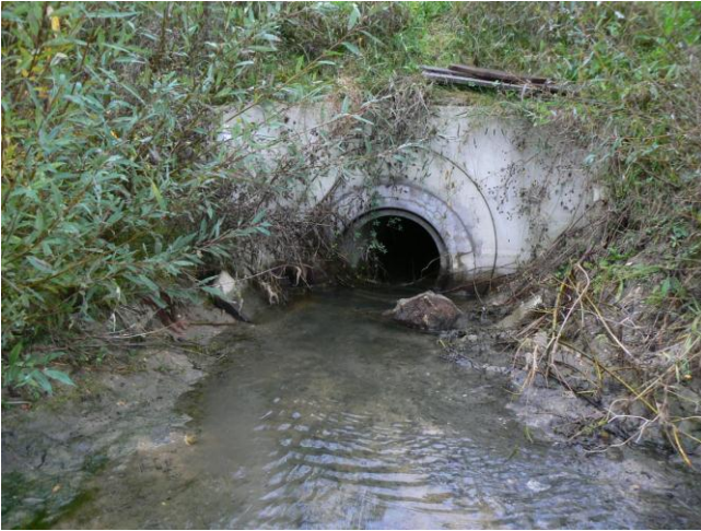
Photo : Bassin n° 1
