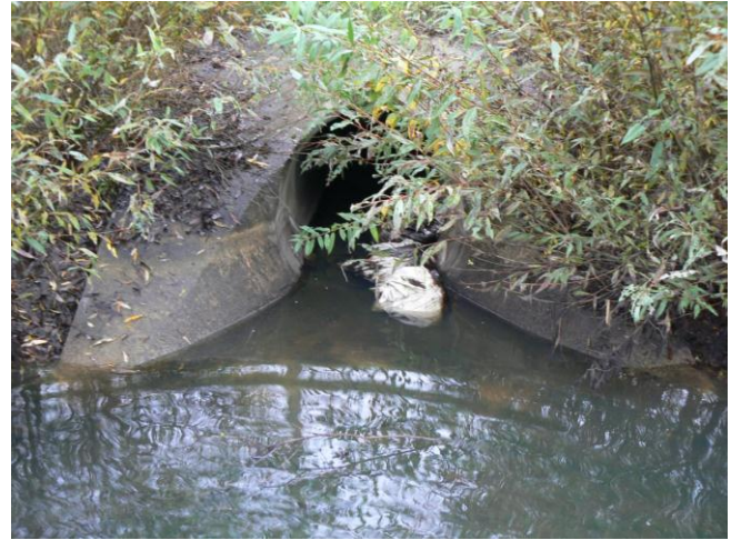
Photo : Bassin n° 2
