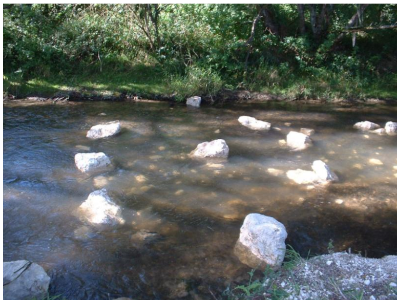
Exemple de mise en place de blocs de manière aléatoire
